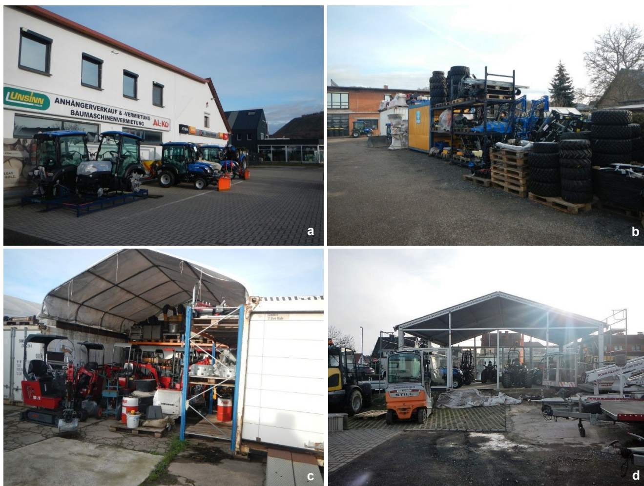
Abb. 5: Gebäude, Container, provisorische Unterstände und Versiegelungsflächen im zentralen Teil des Plangebietes
