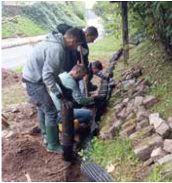
Arbeiten am Haselborn
